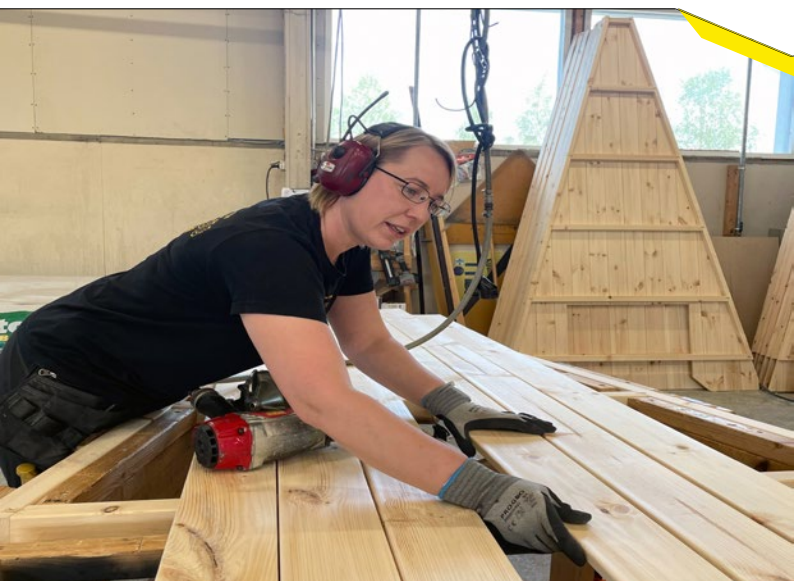
Die Elemente werden in unserem Werk vorgefertigt.
